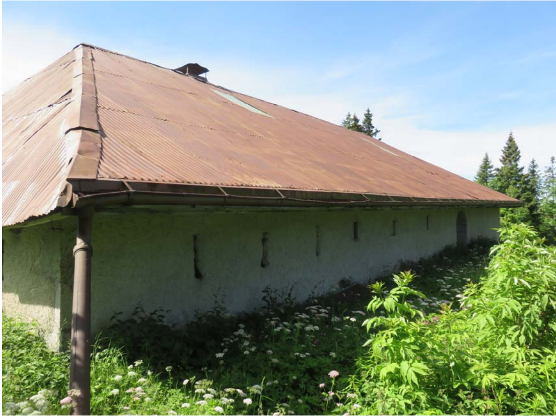
Arrière du chalet, où subsiste la seule chenaux alimentant la citerne recouverte d'une dalle de béton.
