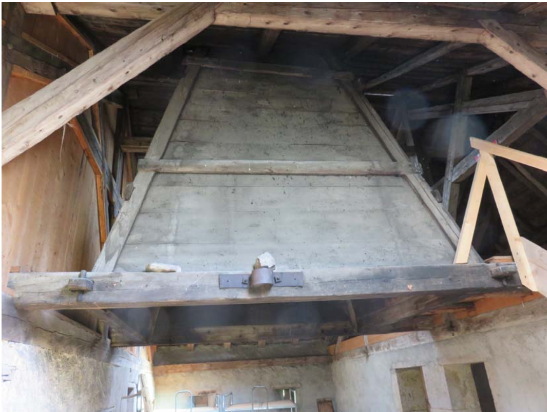
Présence de la cheminée de bois. Au vu de l'intérieur, elle ne nous apparaît pas comme très ancienne. Elle n'en reste pas moins très caractéristique et très belle. La potence pivotait dans l'élément métallique fiché contre l'une des poutres porteuses.
